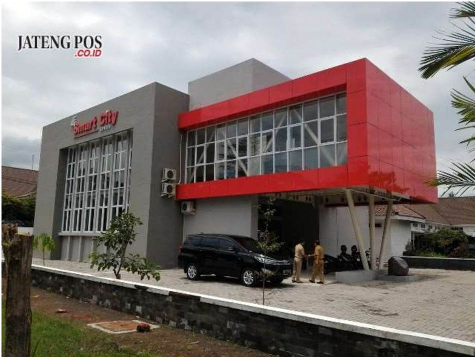
Gambar 3.52 Gedung server (pusat penyimpanan data) Boyolali
